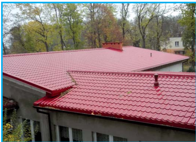
Szkoła we Wrzeszczowie ma teraz nowy dach.
