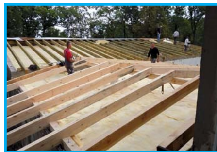
Tak wyglądał remont dachu.
