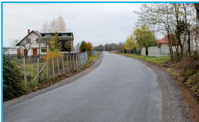
W Wygnanowie wyremontowano ponad 900 metrów drogi
