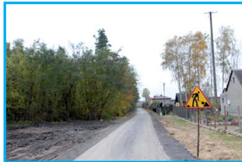
Modernizacja drogi w Kolonii Potkanna.
