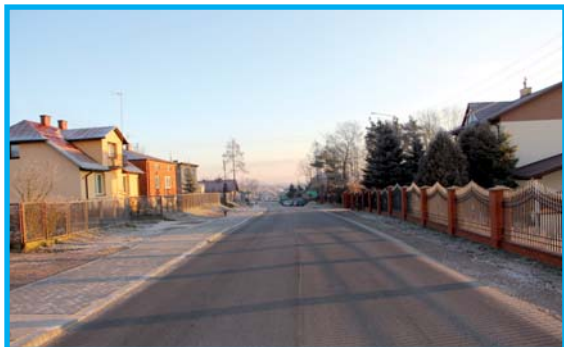
Ulica Kościelna po przebudowie.
