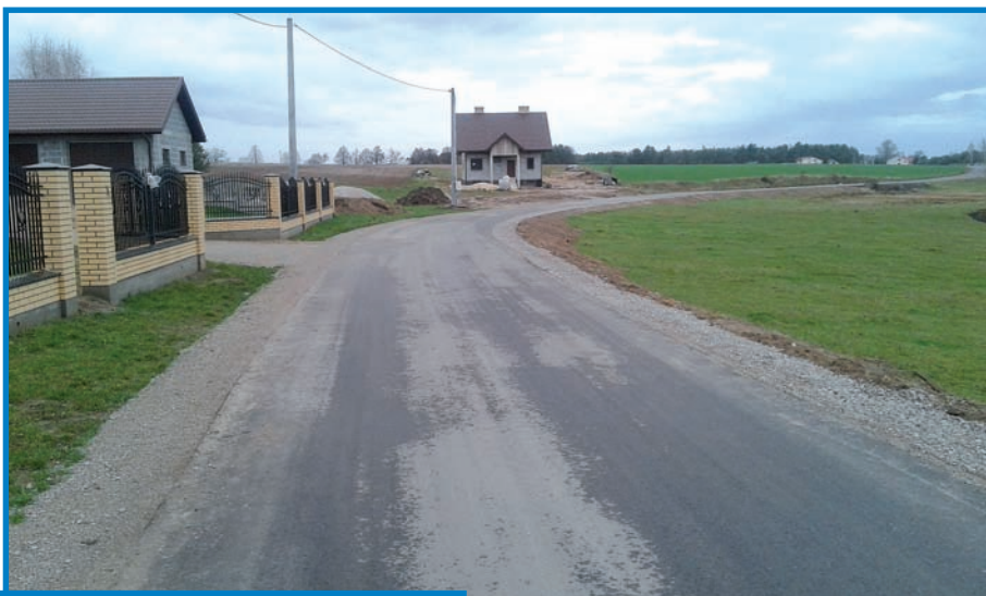
Ponad 900 metrów ulicy Domanowskiej w Przytyku ma po remoncie nawierzchnię asfaltową.
