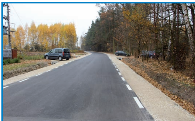
Wyremontowana droga teraz ma 5,5 metra szerokości i wzmocnioną konstrukcję.
