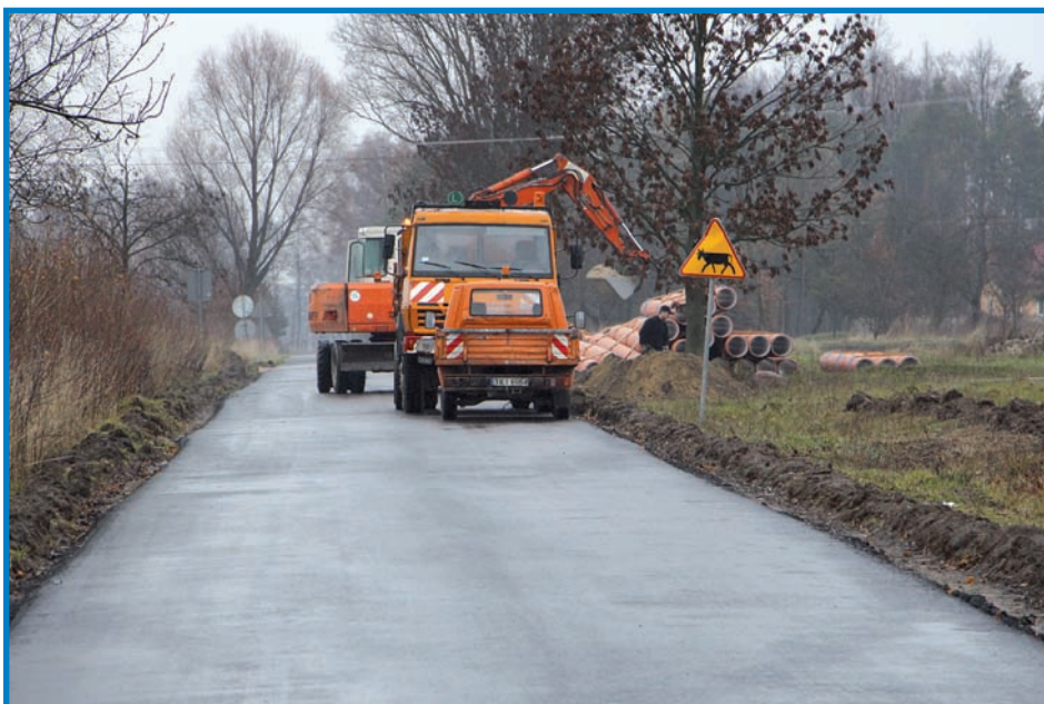
Realizacja drogi powiatowej Wrzos – Wrzeszczów.
