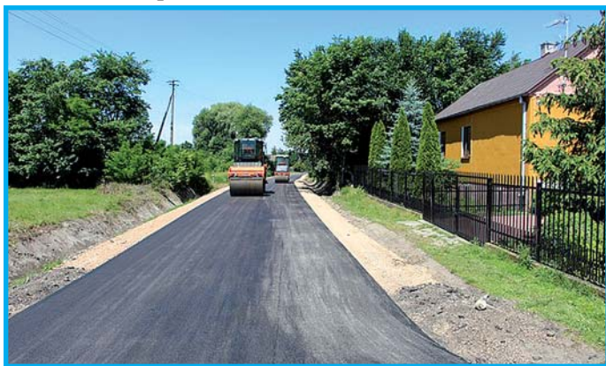
Przebudowa drogi w Kolonii Potkana i Potkana
