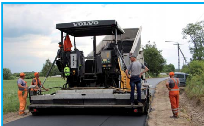
Finalne prace na drodze w Mścichowie
