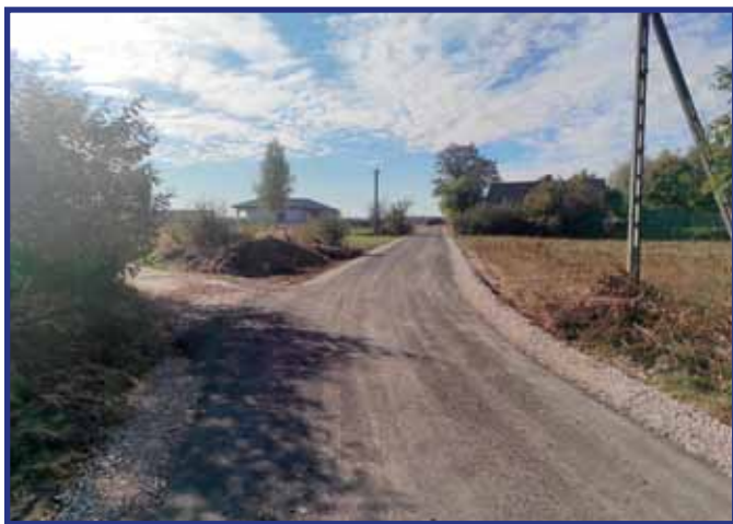
To już druga droga zmodernizowana w miejscowości Ostrołęka przy użyciu destruktu.
