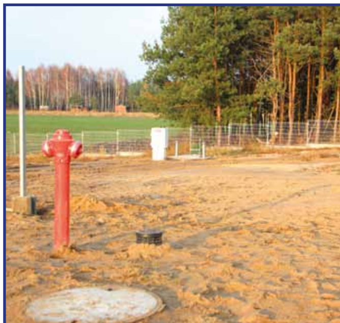
Modernizowana kanalizacja znajduje się w miejscowości Młódnice, niedaleko miejscowości Wólka Domanowska.
