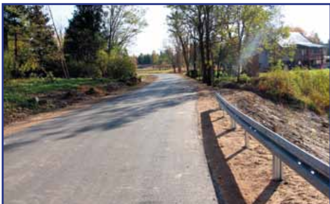
Modernizacja drogi była II etapem prac, które rozpoczęły się w latach poprzednich.
