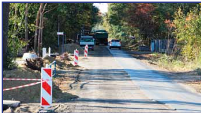
Wykonawcą robót jest firma Strabag Sp. z o.o.
