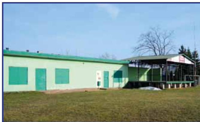
Budynek szatni przed remontem.
