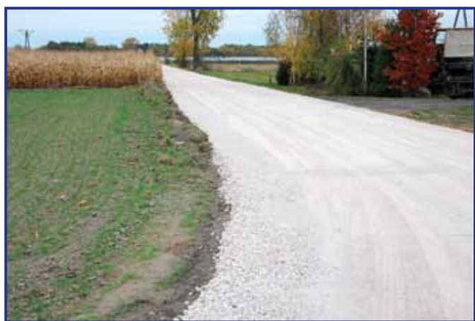
W Woli Wrzeszczowskiej zmodernizowano ponad 1300 metrów drogi gminnej.
