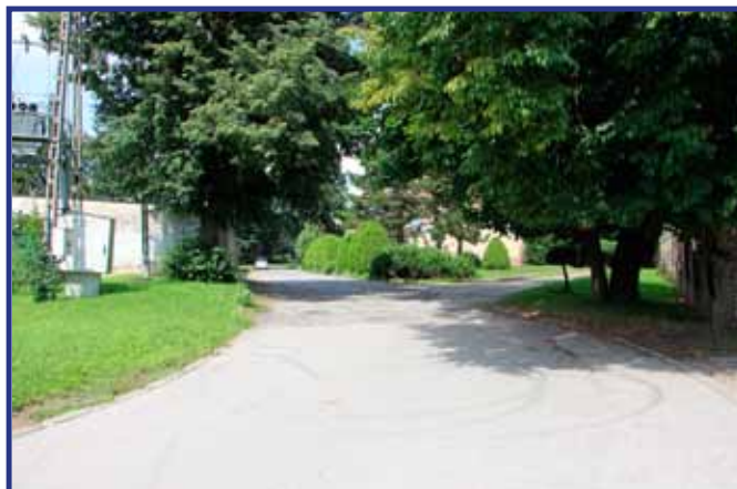
Nowo wybudowana sieć będzie zaopatrywała w wodę budynki wielolokalowe (bloki) położone w miejscowości Zameczek-Kolonia, które to wybudowane zostały na gruntach popegeerowskich.
