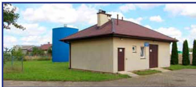
Stacja uzdatniania wody w Glinicach.
