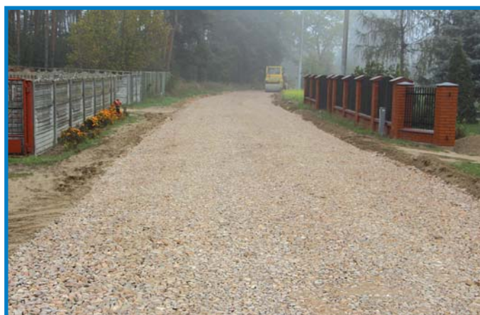
Rozpoczęła się przebudowa ulicy Domaniowskiej.
