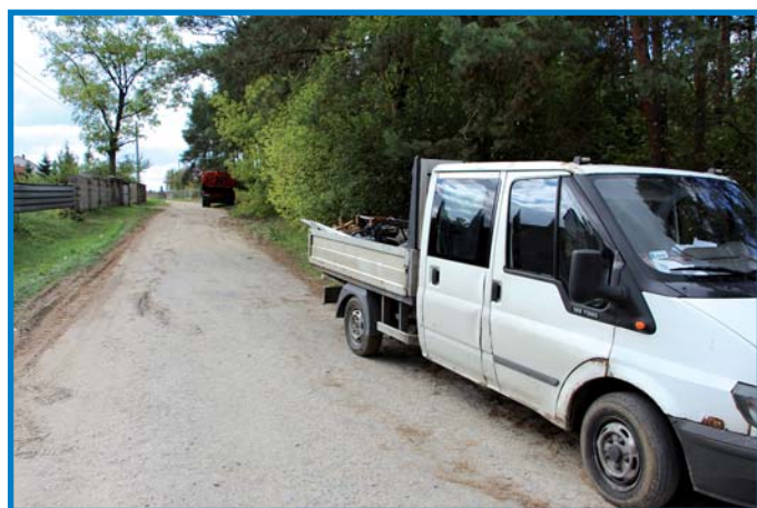
Zamiast drogi gruntowej będzie asfalt.
