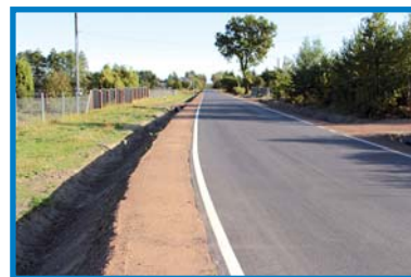
Przebudowa drogi Więcej na stronie 15
