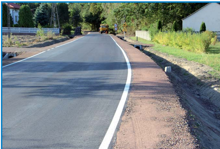
Można już przejechać się wyremontowaną drogą od Przytyka do Wawrzyszowa.
