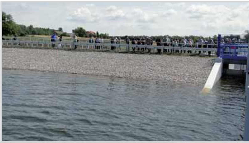
Brzegi zalewu zostały umocnione.
