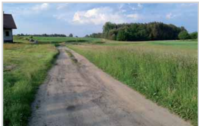
Obecny stan ul. Domaniewskiej
