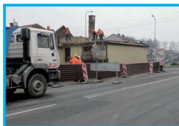
Droga w przebudowie Więcej na stronie 2
