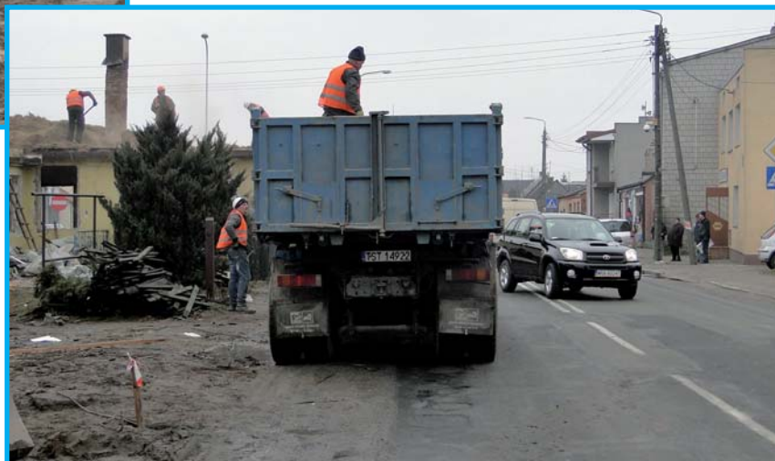
Trwają prace na drodze nr 740.
