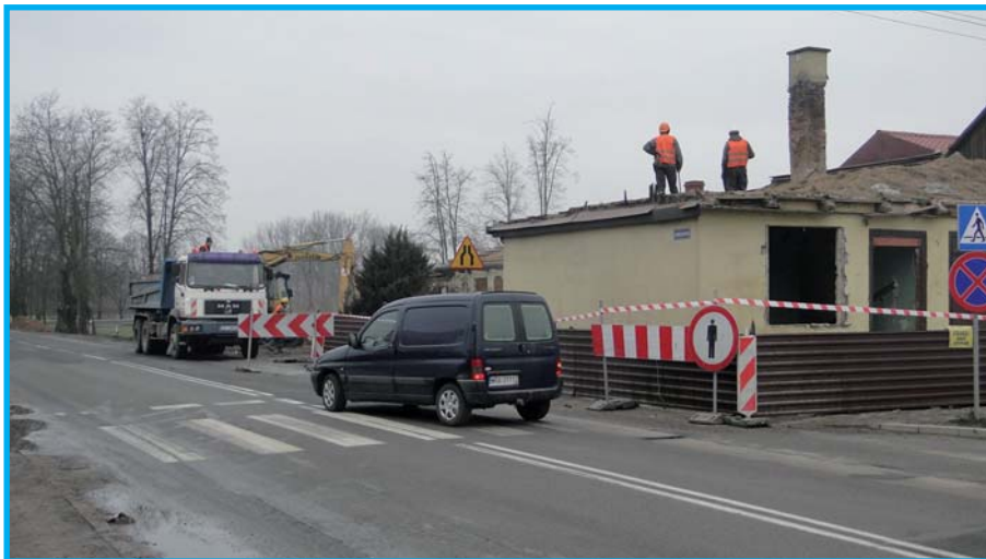
By zmodernizować drogę wojewódzką trzeba było rozebrać dwa budynki na rogu ulicy Tomaszowskiej i Rynku.
