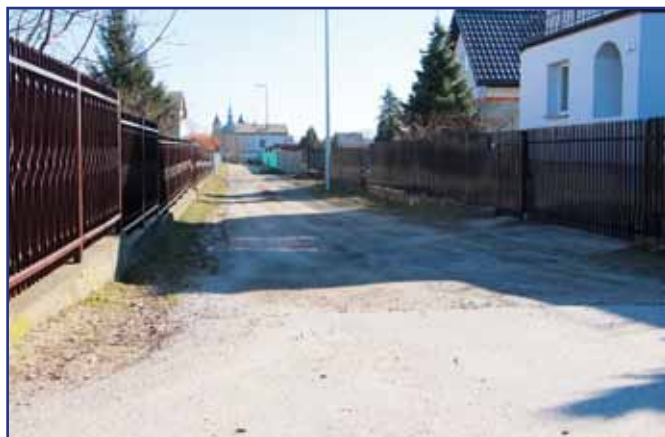
Stan drogi przed pracami remontowymi.
