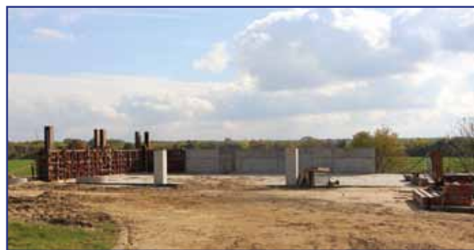
Obecny stan prac w Zameczku Kolonii.
