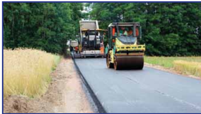
Przygotowanie warstwy bitumicznej.
