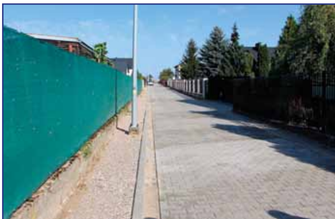
Odbiór zmodernizowanej ulicy odbył się pod koniec sierpnia.
