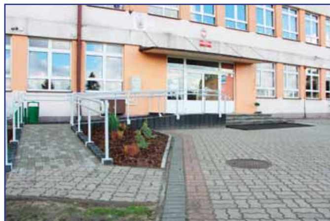
Przebudowa wejścia do szkoły to kolejny krok w sprawie dostępności budynków użyteczności publicznej.
