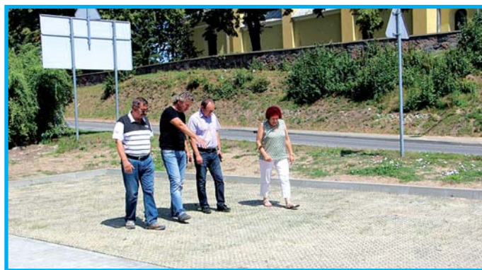
Podczas odbioru obecni byli wójt gminy Przytyk, pracownicy Urzędu Gminy oraz wykonawca prac.
