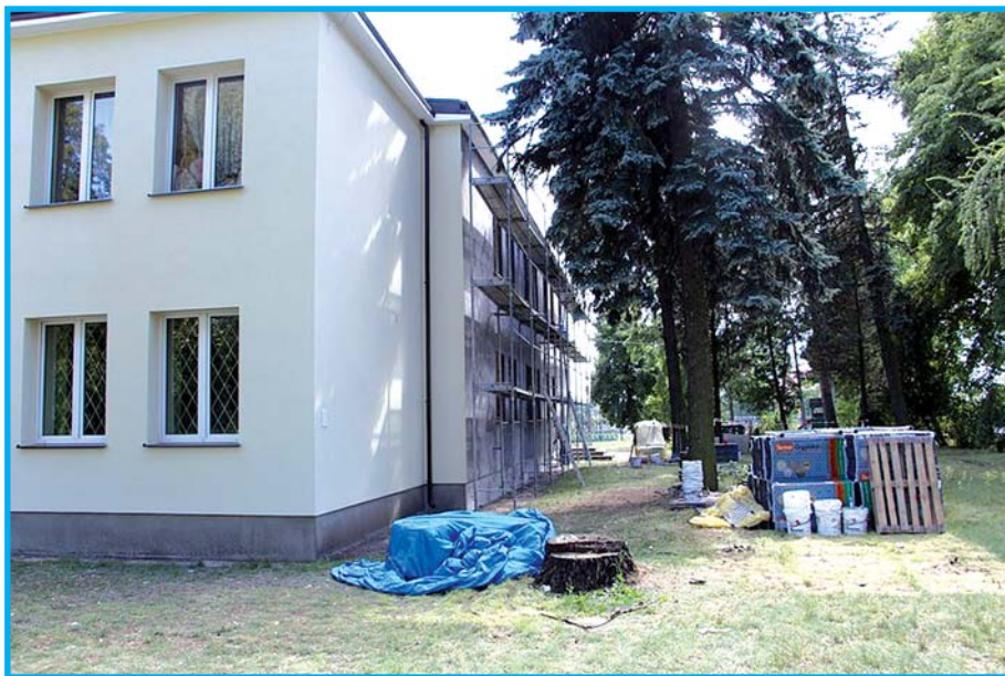
Na części budynku prace dociepleniowe już zostały zakończone.
