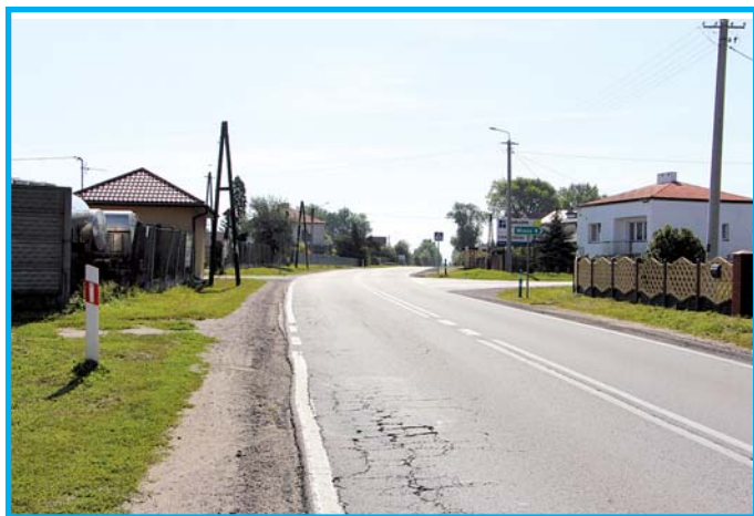
W planach inwestycyjnych w miejscowości Wrzeszczów jest przebudowa drogi wojewódzkiej 740 oraz budowa chodnika dla pieszych.
