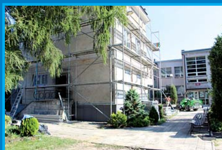
Termomodernizacja szkół. Więcej na str. 11.
