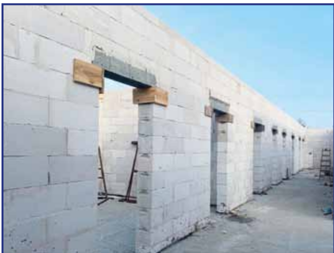
Stan prac na ostatnie dni marca.
