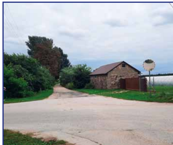
Planowana inwestycja połączy miejscowości Wrzos i Wygnanów.
