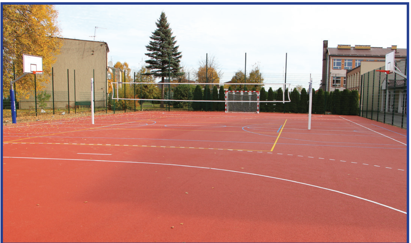
Zmodernizowane boisko szkolne znajdujące się przy PSP w Przytyku.
