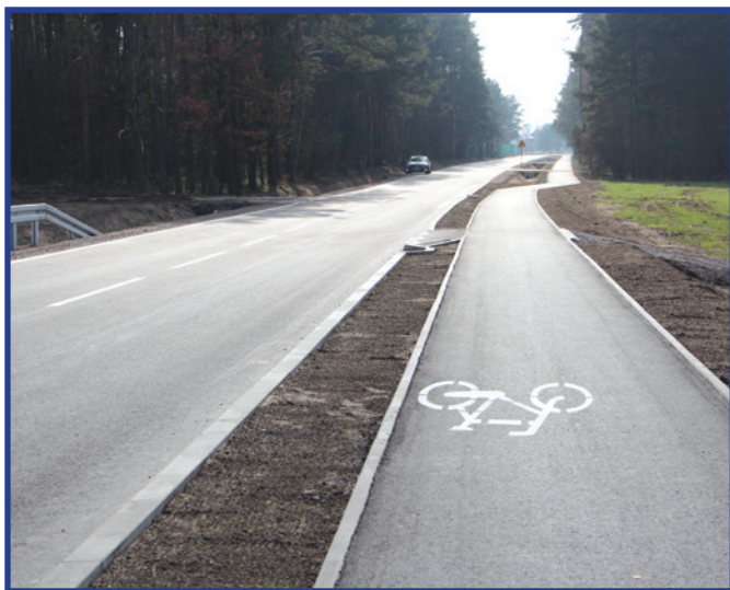
Na całej długości przebudowanego odcinka powstała ścieżka rowerowa o szerokości 2 metrów.
