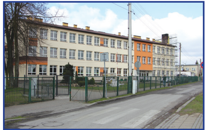
Termomodernizacja PSP w Przytyku została również wsparta funduszami zewnętrznymi. Dotacja na to zadanie pochodziła z budżetu Samorządu Województwa Mazowieckiego.
