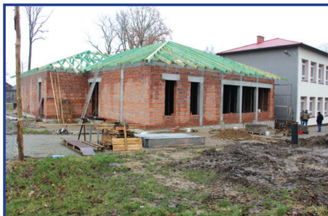
Prace przy budowie nowego skrzydła PSP we Wrzeszczowie.
