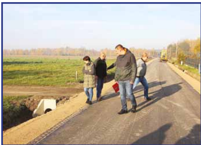
Przebudowana jezdnia posiada 4-metrową szerokość.
