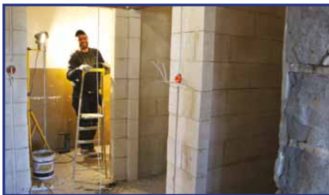
Prace przy budowie sanitariatów.
