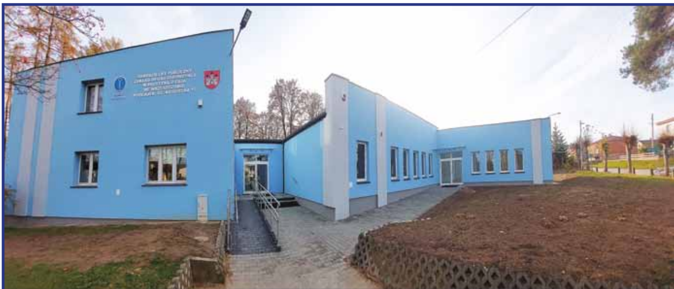
Nowopowstałe skrzydło zostało połączone z dotychczasowym budynkiem przychodni.
