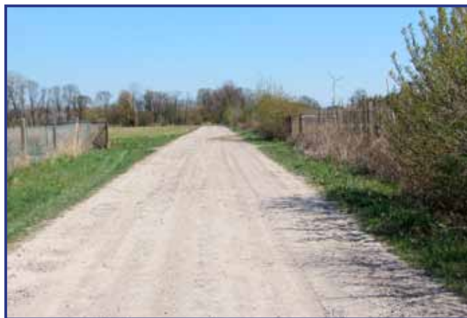
Droga posiada już podbudowę do dalszej modernizacji jezdni.
