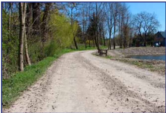
Obecny stan drogi.
