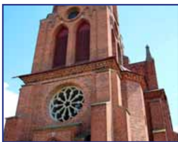
Pod koniec maja przygotowywano otwory okienne do montażu witraży.
