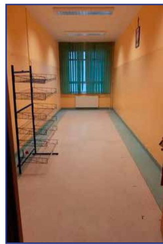
Tak wyglądało jedno z pomieszczeń przed remontem.
