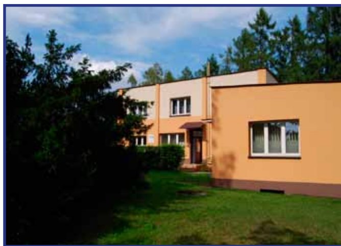
Obecny stan budynku SPZOZ-u w Przytyku.
