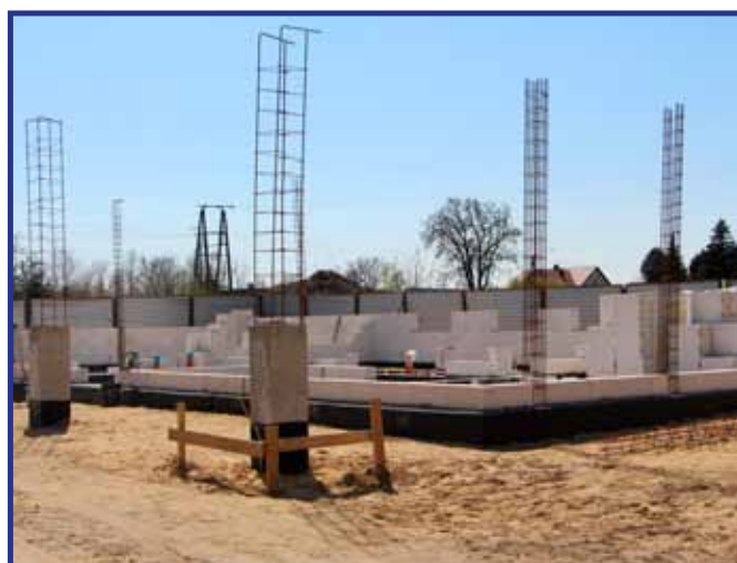
Stan budowy obiektu w miesiącu kwietniu.
