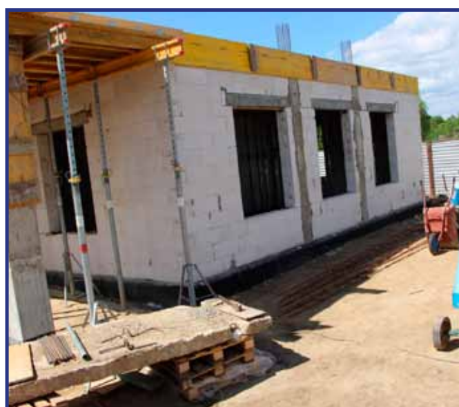
Stan budowy obiektu w miesiącu czerwcu.
