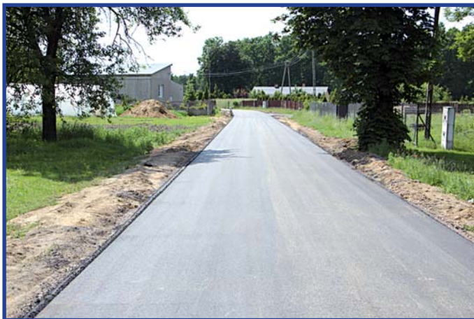
Droga w Posadzie ma już nową nawierzchnię.
