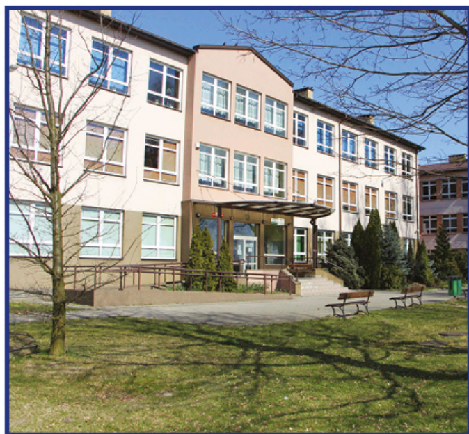
Siedziba Filii Powiatowego Urzędu Pracy – dojazd od ul. Szkolnej oraz ul. Żeromskiego.
