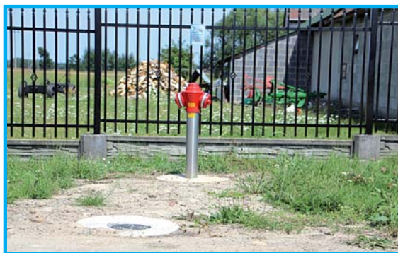
W lipcu zakończyły się prace przy budowie sieci wodociągowej w miejscowościach Ostrołęka i Kolonia Potkana.
