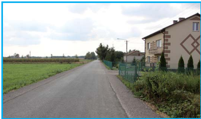
Również w Domaniowie oddano do użytku nową asfaltową drogę wraz z pobocznymi z kruszywa.
