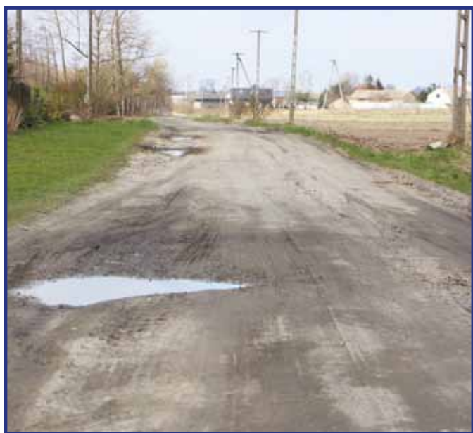
Obecny stan drogi w miejscowości Wygnanów (Wygnanów Pomorze)
