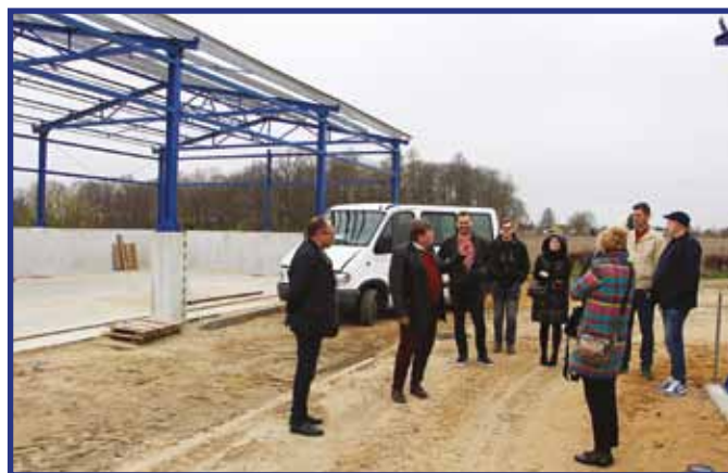
W kwietniu odbył się częściowy odbiór prac, który wskazuje na terminowe wykonywanie poszczególnych etapów inwestycji.
