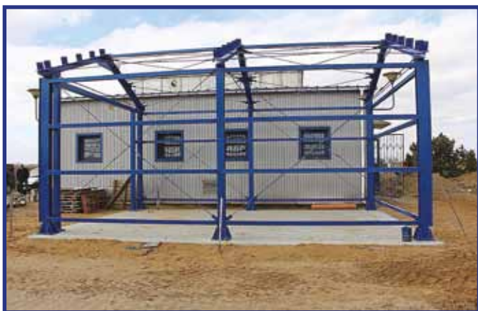
Obecny stan prac.
