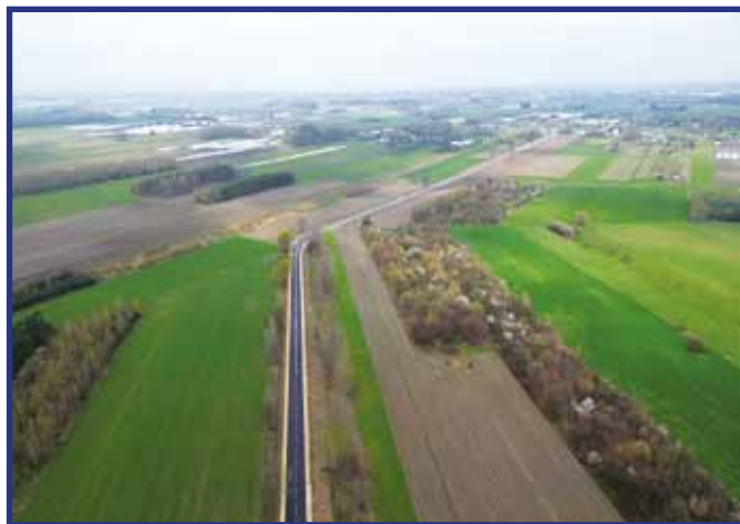
Remont objął blisko 3-kilometrowy odcinek drogi.
