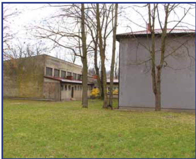
Miejsce, w którym zostanie dobudowane nowe skrzydło placówki we Wrzeszczowie.
