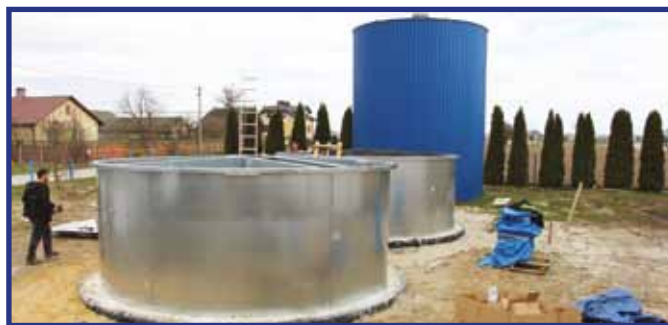
Montaż zbiorników na wodę.
