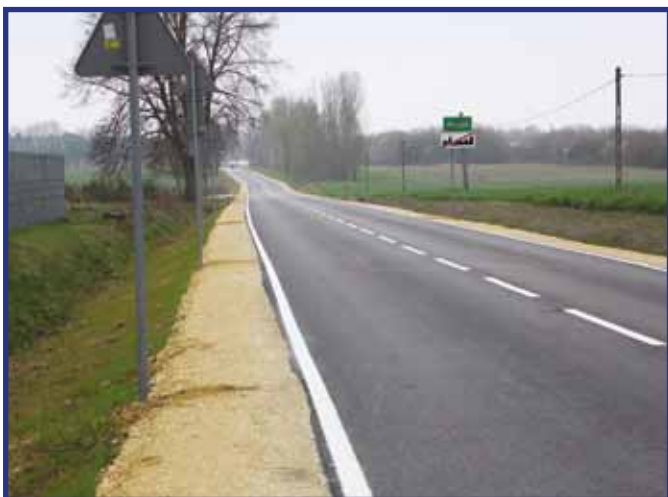
Obecny stan drogi powiatowej Przytyk-Studzienice.
