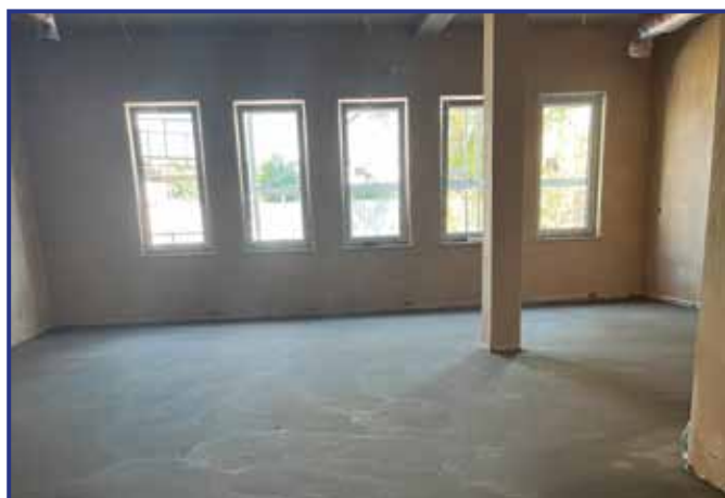
Stan prac rozbudowy ośrodka zdrowia na miesiąc lipiec.
