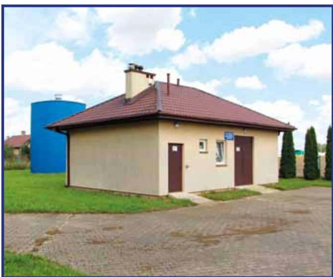
Obecny stan stacji uzdatniania wody w Glinicach.
