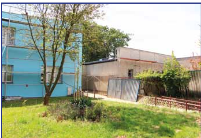
Rozbudowa ośrodka zdrowia obejmuje również remont starego skrzydła obiektu.
