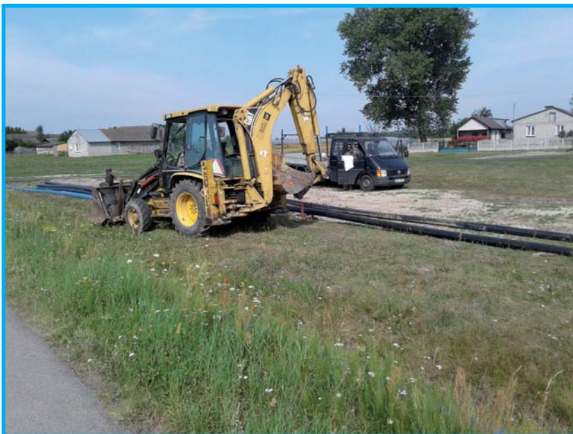
Prace przy budowie sieci wodociągowej
