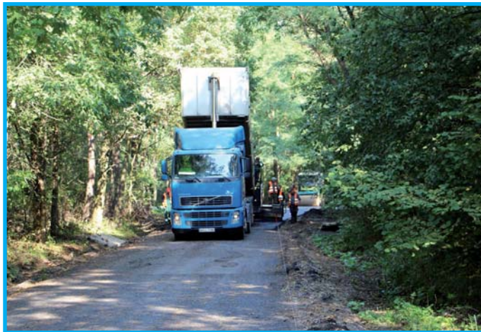
Droga w trakcie przebudowy
