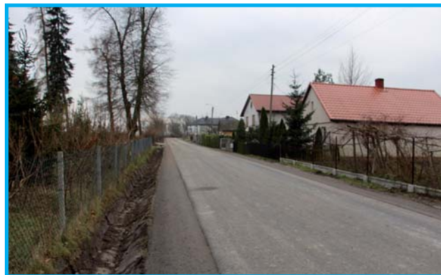
Droga po modernizacji wraz z wykonanymi poboczami
