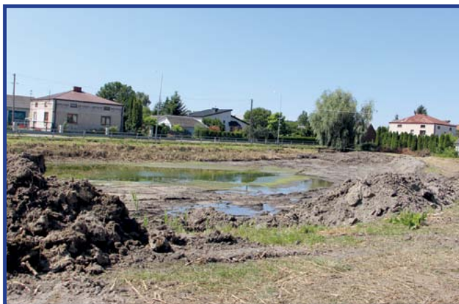
Pierwsze prace przy zbiorniku wodnym polegają na jego oczyszczeniu.
