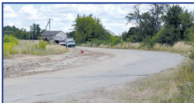
Kolejny odcinek drogi powiatowej zlokalizowanej na terenie naszej gminy wzbogaci się o ciąg rowerowy.
