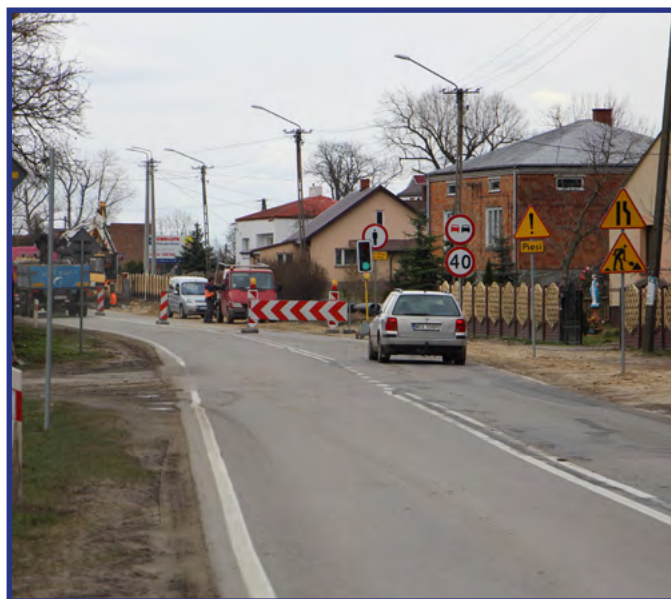
W związku z prowadzonymi pracami wprowadzono ruch wahadłowy.
