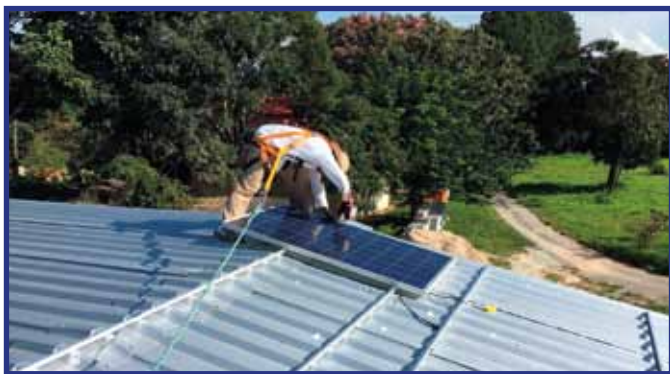
Mieszkańcy, którzy otrzymali dotację, instalują już na swoich dachach panele fotowoltaiczne.
