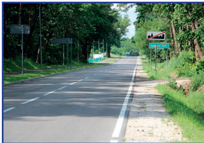
Stan drogi po przebudowie.
