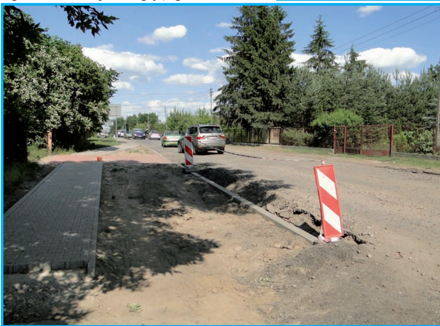
Ulica Kościelna będzie zmodernizowana.
