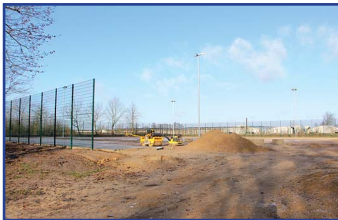
Plac budowy przy PSP we Wrzeszczowie.
