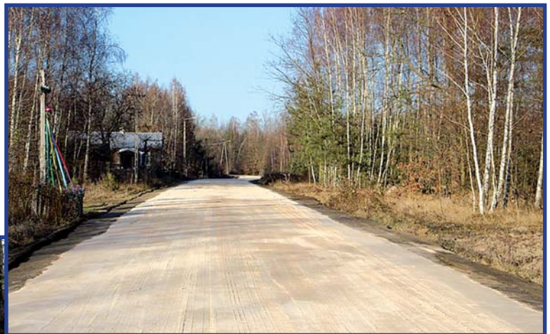
Rozbudowana droga gminna w miejscowości Witoldów.
