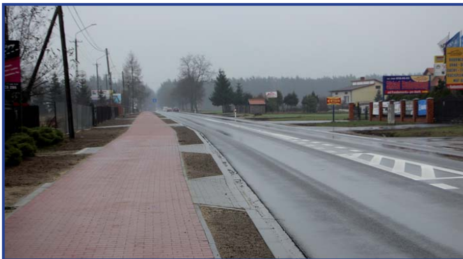
Na początku grudnia odbył się odbiór prac przebudowywanej drogi wojewódzkiej 740.
