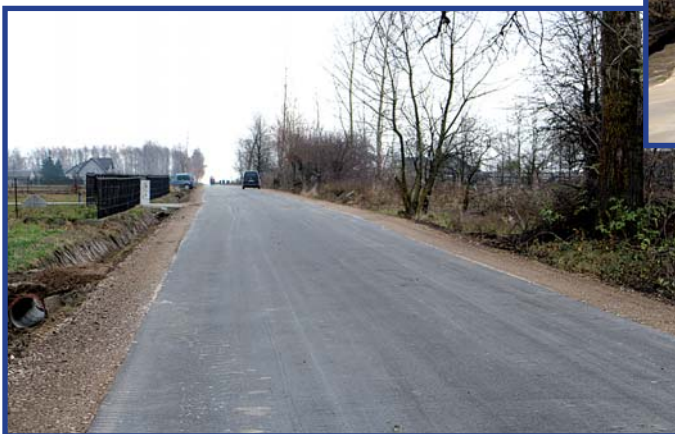
Droga gminna nr 350912W w miejscowości Suków została przebudowana oraz otrzymała nawierzchnię asfaltową.
