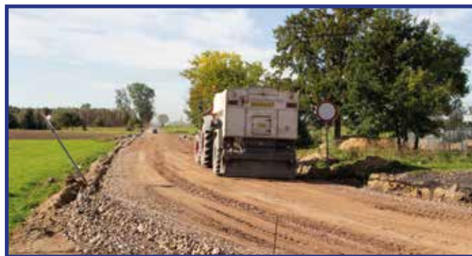
Wykonawcą robót była firma Budromost- Starachowice z Wąchocka.
