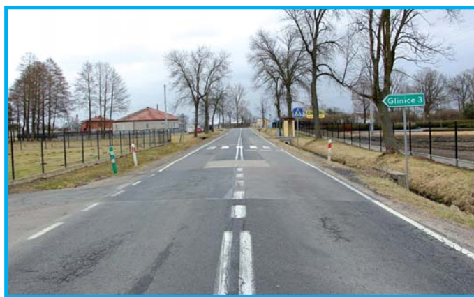
Jeszcze latem remont drogi ma być skończony.
