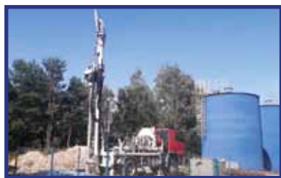
Prace podczas budowy studni w Wólce Domanowskiej.
