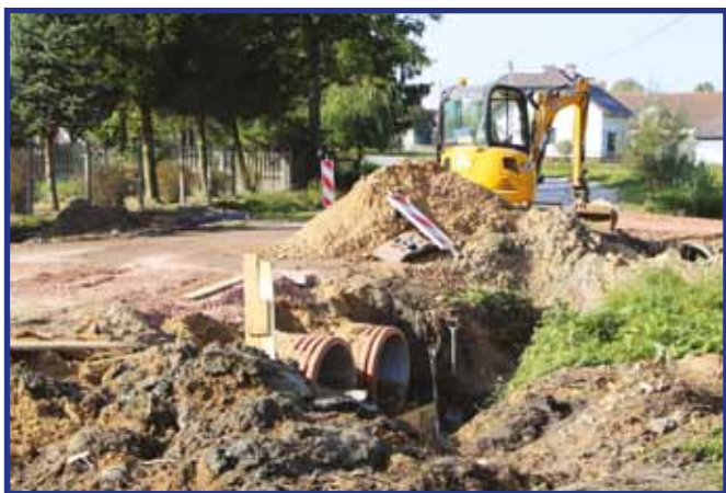
Prace w miejscowości Glinice wymagały użycia ciężkiego sprzętu.
