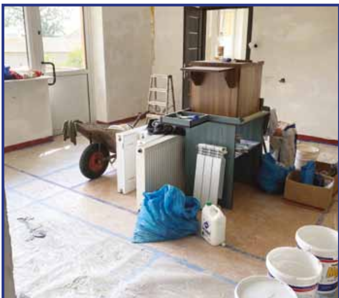
Prace remontowe objęły swym zakresem wygładzenie ścian i ponowne ich malowanie.
