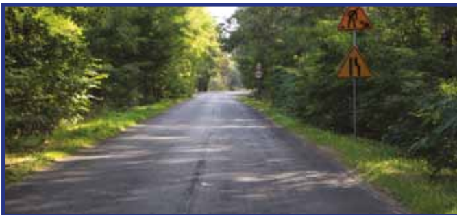
Rozpoczęcie prac przy drodze Przytyk – Wrzos.
