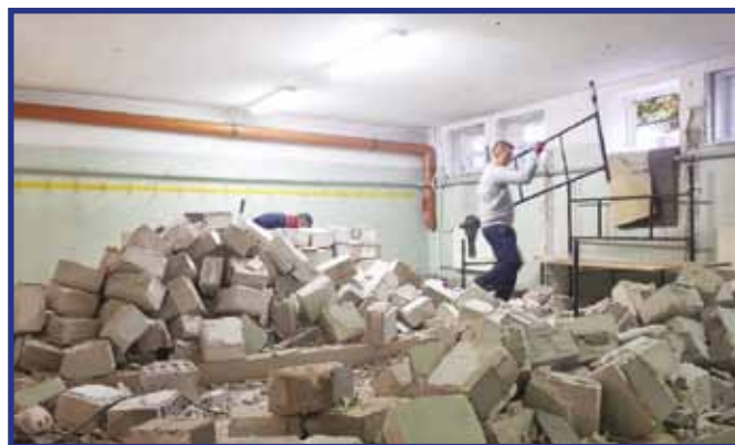
Burzenie ścianek działowych to pierwszy krok do powstania nowej siłowni.
