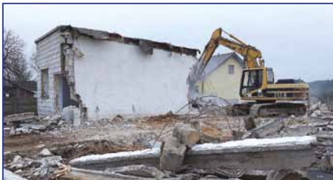
Stary budynek Ochotniczej Straży Pożarnej we Wrzosie został wyburzony. Wkrótce na jego miejscu zostanie wybudowana nowa siedziba OSP, spełniająca również funkcję domu ludowego.
