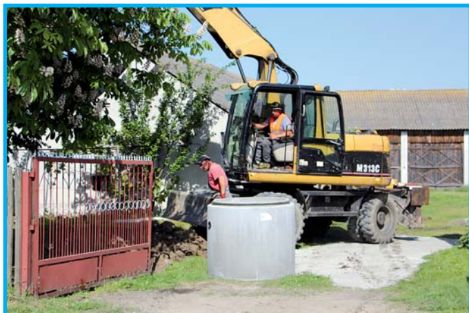
Prace obejmowały wykonanie studni wodomierzowych betonowych.
