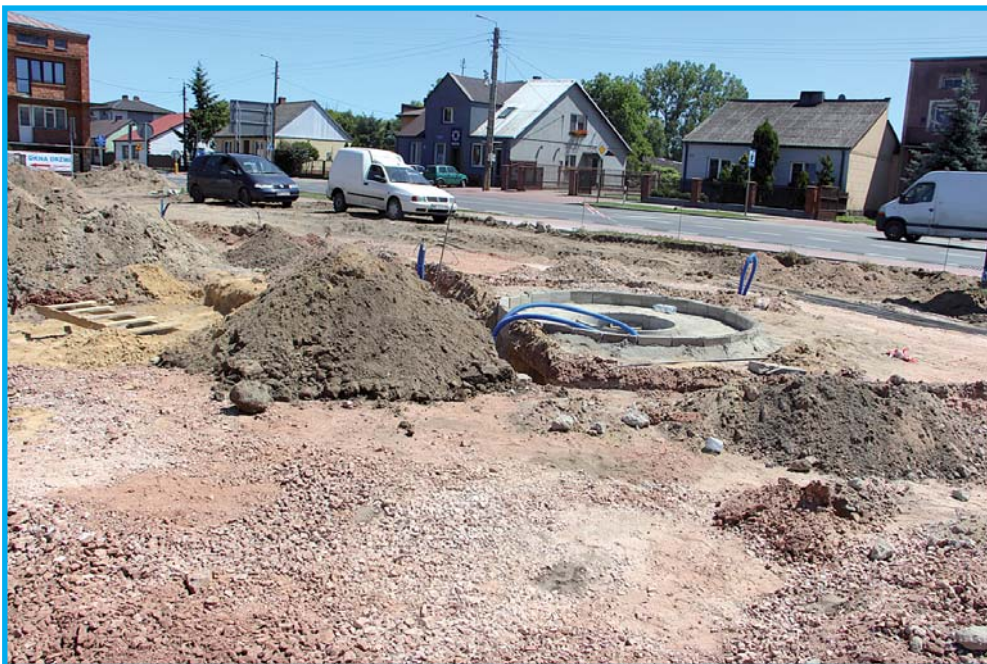
Na placu budowy można odnaleźć już miejsce docelowe dla fontanny.
