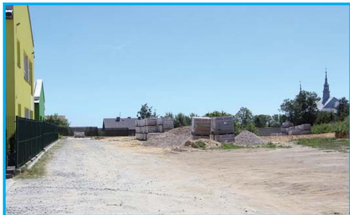
Ulica Żeromskiego zmienia się w plac budowy.
