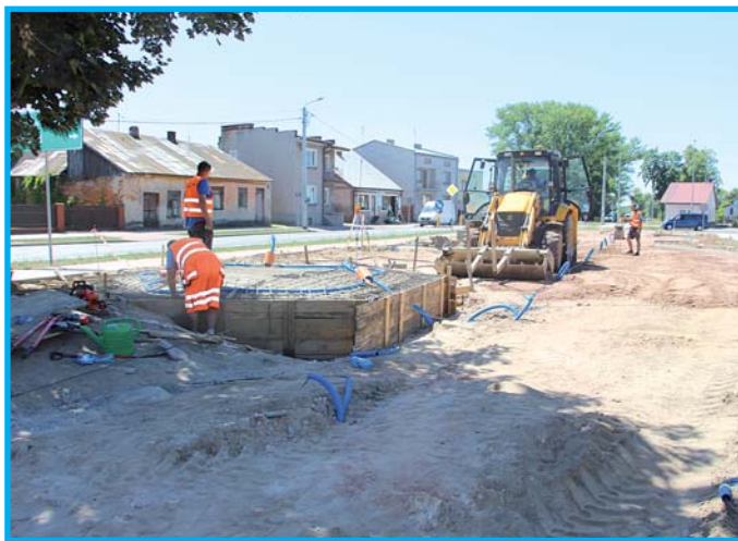
Prace przy przebudowie przytyckiego rynku.
