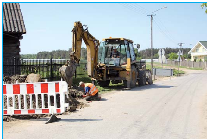
Budowa sieci wodociągowej.
