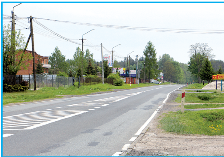
Obecny stan drogi wojewódzkiej 740 w miejscowości Obles.
