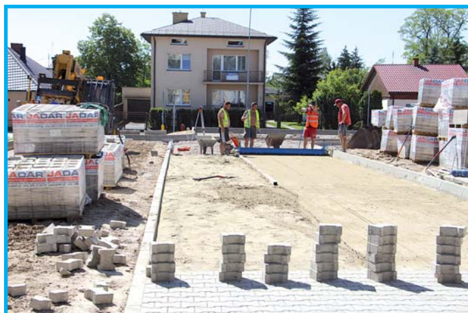
Kolejny etap prac – układanie kostki brukowej.
