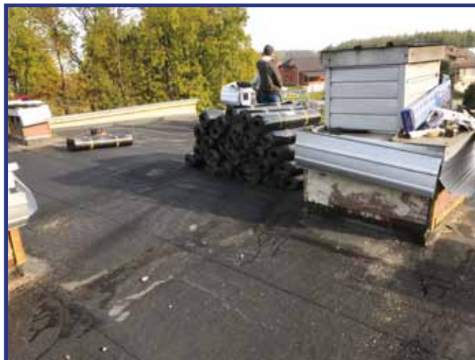
Prace remontowe przebiegały zgodnie z harmonogramem.
