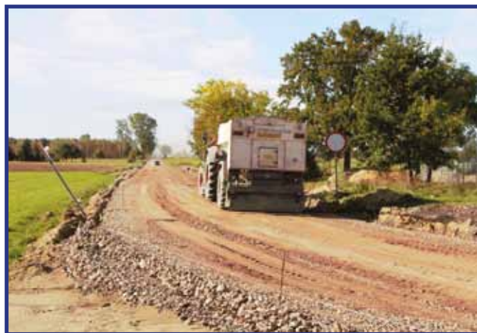
Przygotowanie drogi gruntowej pod nową nawierzchnię.
