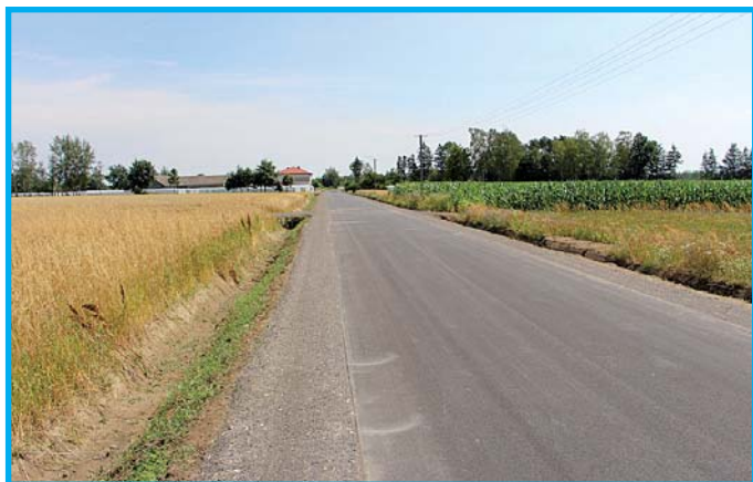
Efekt finalny zmodernizowanego odcinka drogi w Mścichowie
